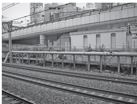
図1——立会川への地下水の送水管(2009年6月17日大井町駅から撮影)。
